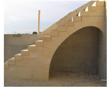
Arc rampant sous un escalier
